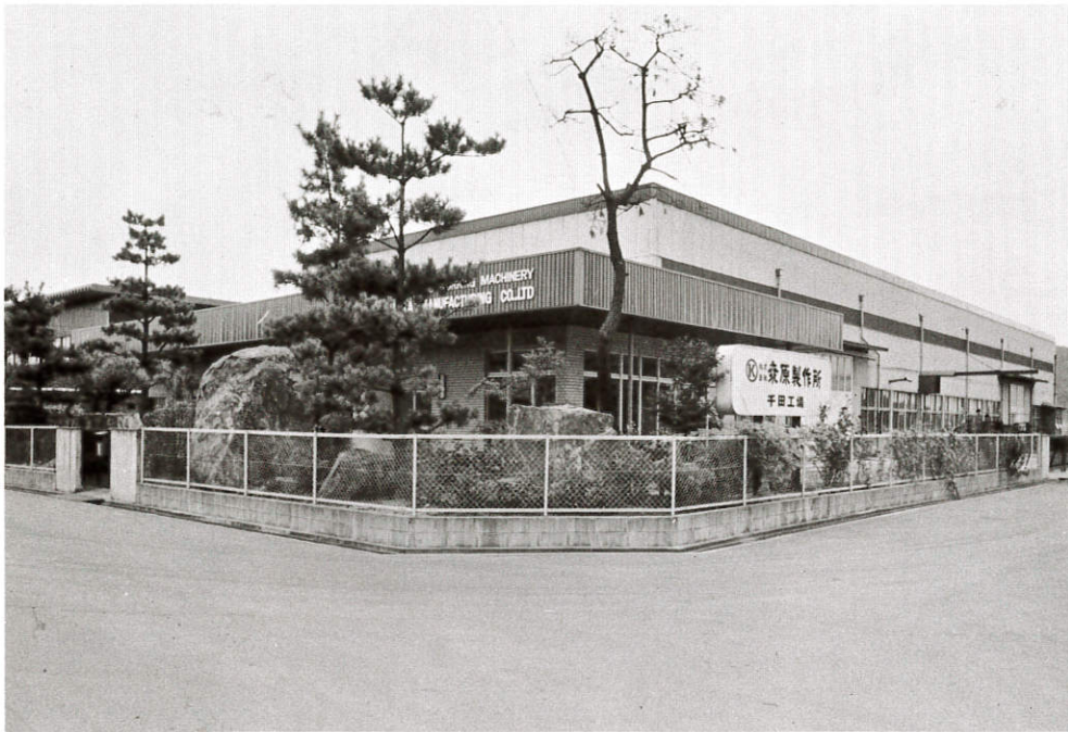
横切丸のこ盤専門工場(千田工場)
